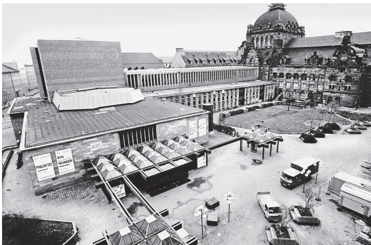
An einer Schließung kam das Schauspielhaus vor 25 Jahren einfach nicht vorbei. Es war derart asbestverseucht, dass es generalsaniert werden musste. Foto: Eduard Weigert
